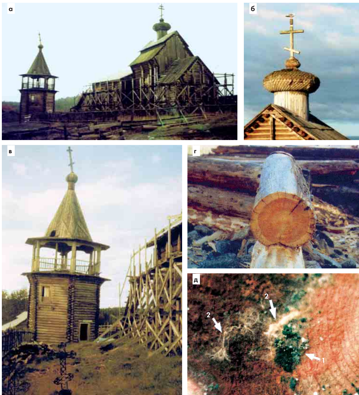
Рисунок 2. (а) — церковь без обшивки, но до разборки (1992 г.); (б) — двойная главка ковдской церкви; (в) — колокольня до разборки (1992 г.); (г) — спил старого бревна из колокольни; (д) — образец с северной стороны трапезной (наиболее поврежденной), находящийся во влажной камере 10 дней: мицелий триходермы (1) вытесняет дереворазрушающий гриб кониофору (2).
